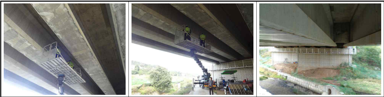
[고소작업차를 이용한 근접조사 실시]
