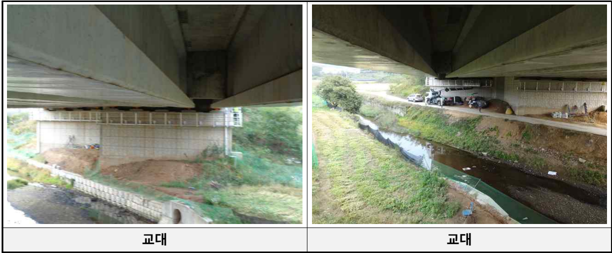
[교대 및 교각 전경]
